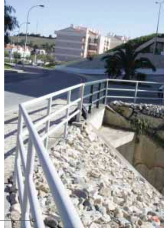
Colocação de drenagens pluviais e protecções para peões na ponte sobre a Ribeira das Salemas, em Arruda dos Vinhos.
